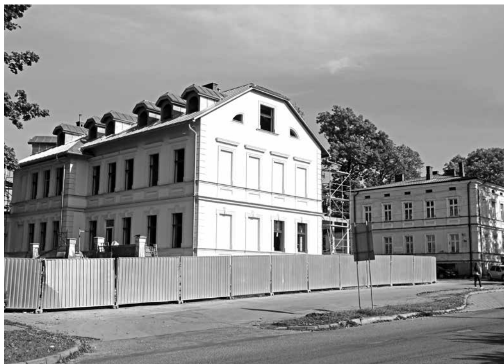
Trwa remont zabytkowych budynków - „starej gminy” i pałacyku Dietla (fot. R. Jaworski)
