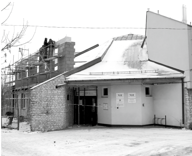
Przebudowa Ośrodka Zdrowia
