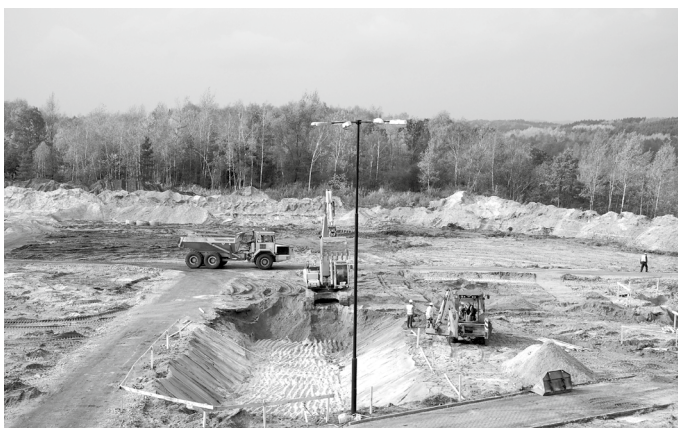
Budowa hali produkcyjnej pod nową maszyną papierniczą.
