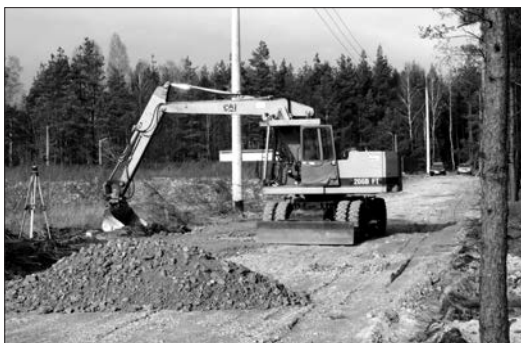
Budowa drogi tłuczniowej w Kluczach-Osadzie.
