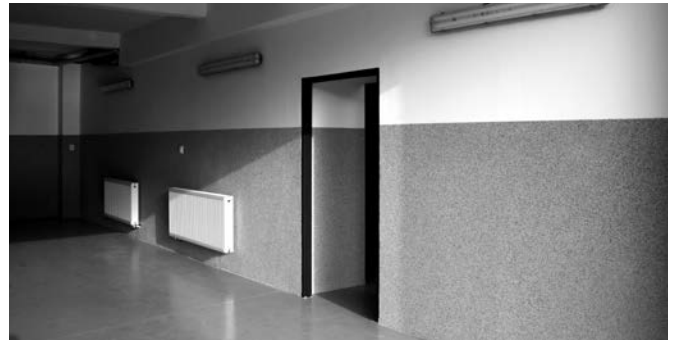
Dzięki dotacji z konkursu „Małopolskie Remizy 2015” wyremontowano pomieszczenia w siedzibie OSP w Chechle.
