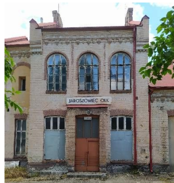
Ryc. 4 Stacja kolejowa, ul. Kolejowa 1d, Jaroszowiec.
